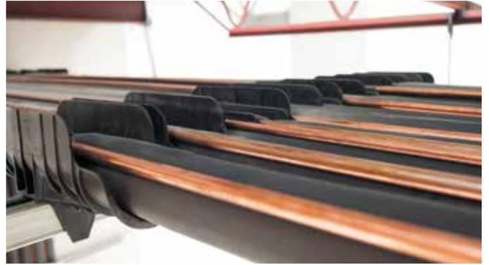
Los soportes tipo silla Insuguard tienen paredes altas que protegen las líneas de líquido de los montantes, las barras roscadas y los soportes, y soportan la carga de la tubería sin puente térmico.
