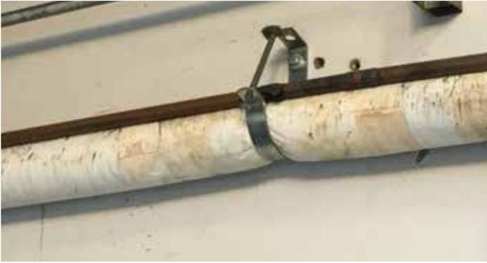
La compresión del aislamiento en los puntos de suspensión rompe la barrera térmica. Esto produce puente térmico y puede causar condensación, puntos de congelamiento y crecimiento de moho.
