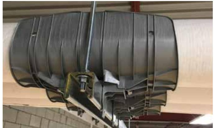
El diseño revolucionario con bordes curvados del soporte tipo silla Insuguard permite que la tubería aislada se expanda y vibre dentro del soporte, sin posibilidad de desgarramientos.
