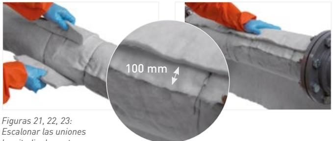
Figuras 21, 22, 23: Escalonar las uniones longitudinales entre capas.
