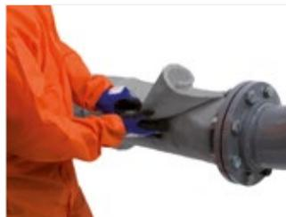
Figura 25: Continuar envolviendo alrededor de la tubería para llegar a la cantidad requerida de capas. Finalice la envoltura con el borde longitudinal alineado con el punto de inicio de la capa interior o superpuesto al mismo.
