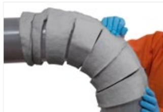
**Figura 39:** Colocar los recortes en la garganta interna del ángulo con la junta longitudinal en la parte exterior de la curva.
