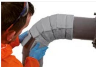
**Figura 36:** Atar cada sección con alambre, permitiendo que tengan movimiento para el ajuste final.
