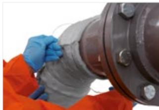
**Figura 35:** Asegurarse de que todas las juntas estén bien unidas sin separaciones y de que se ajusten bien a la tubería sin vacíos.
