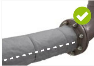
Figura 17: Rotar la unión longitudinal a un lado.
