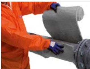
Figura 24: Asegurarse de que el punto de inicio esté alineado con el eje de la tubería. Es posible que sea necesario usar cinta o adhesivo para sostener en la posición axial.
