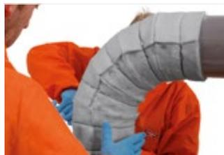
**Figura 37:** Juntar todas las secciones para asegurarse de que no haya separaciones en las juntas y ajustar los alambres.
